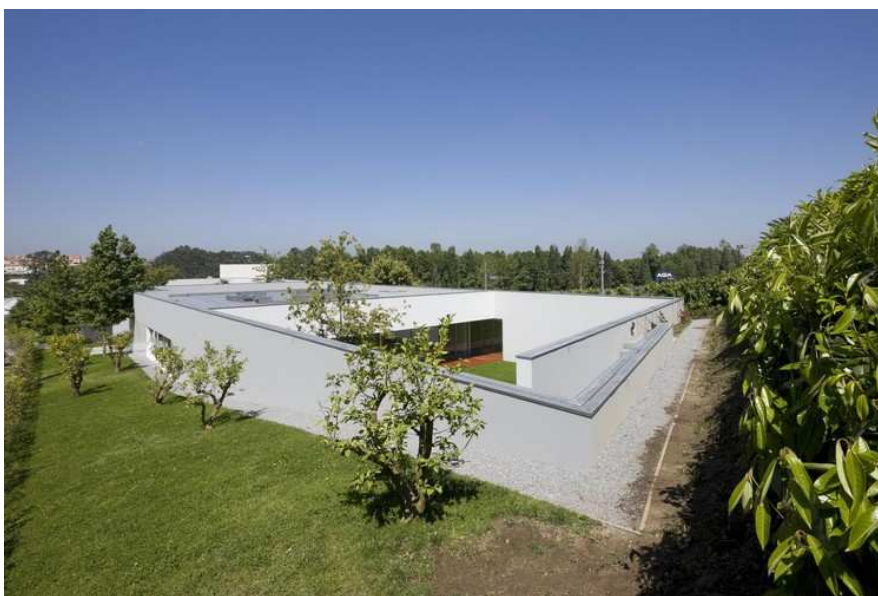
Casa na Rua do Lindo Vale / Ana Cláudia Monteiro + Vítor Oliveira
